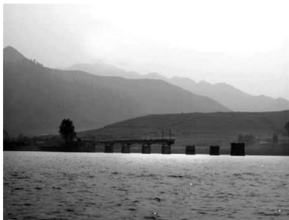
Die meisten Brücken in Richtung China wurden zerstört!
